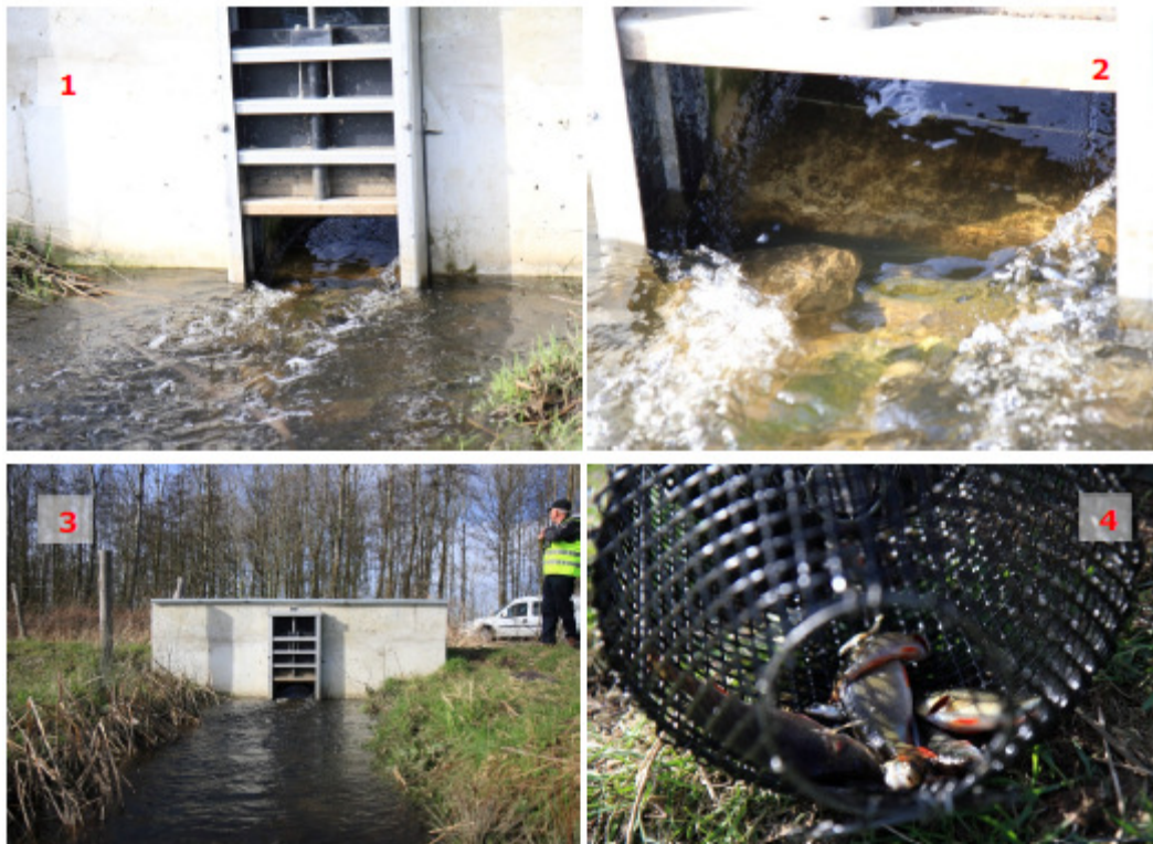
Figuur4 : 1) openzetten klein stuwte van visvriendelijke stuw; 2) detailopname waterkolom; 3) een Kruijn-vrijwilliger op weg om de fuik op te halen en 4) de fuik met daarin de vangst van de dag.
