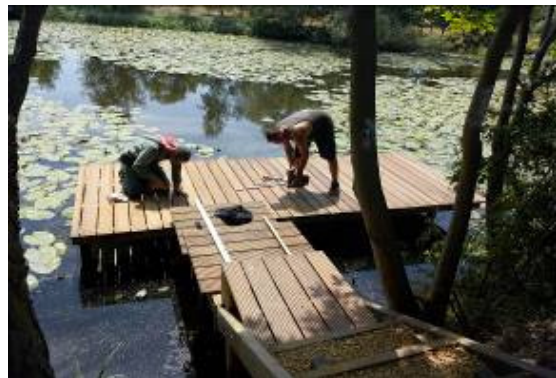
bouw vissteigers Bazelse Kreek
