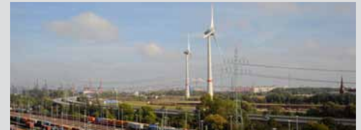
54 Wind turbines, Altenwerder
