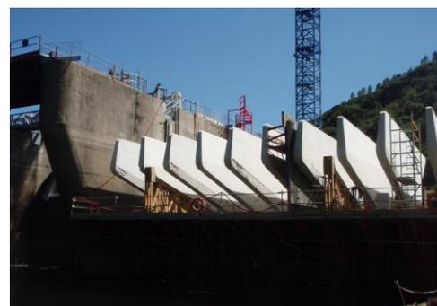
Dans une volonté **d'amélioration permanente de la sûreté et de la sécurité**, EDF a investi 4 millions d'euros pour construire sur le barrage de Malarce ce dispositif complémentaire. Fruit de nombreuses études, le dispositif retenu est dit Piano Keys Weir, signifiant en « **touches de piano** ».
