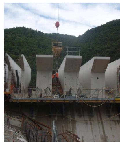
Le nouvel évacuateur de crue de Malarce est **le 6<sup>ème</sup> dispositif Piano Keys Weir construit en France par EDF**. C'est, en outre, **le plus long**. Il a également **le débit d'évacuation le plus important** et **les portes à faux amont et aval les plus importants** (6,63 m à l'amont, 2 m à l'aval).
